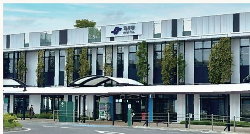
仙台市地下鉄東西線「荒井」駅 徒歩18～19分(約1,400～1,450m)
