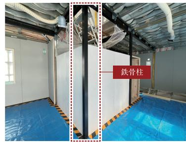
厚さ3.2mm、80mm角の1階鉄骨柱。約5寸角の檜柱の強度に相当し、建物をしっかりと支えます。
