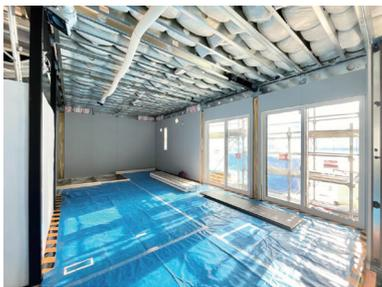
新幹線や航空機でも用いられるモノコック構造。地震や台風などの外力を、面全体で受け止め、建物全体にバランスよく分散し、優れた耐震性を発揮します。
