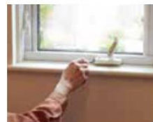
【サッシ・建具の点検】
