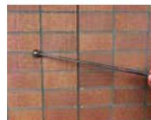
【打診棒による外壁点検】
